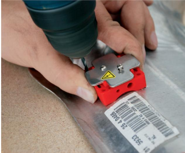
**Spannungsgeladen:** Die Kontaktplatten der Weidezaun-Anlage lassen sich mittels Kabelbinder oder (wie hier im Bild) mit Schrauben befestigen. Bild: Mareis
